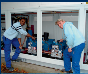
Inbetriebnahme einer Kälteanlage
